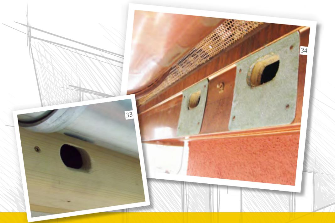
**Materialien:** Geeignet sind unbehandeltes, witterungsbeständiges Holz, Siebdruck- oder Faserzementplatten. Werden Nistplätze im Traufkasten eingerichtet und dieser mit Blech verkleidet, so muss unterhalb der Einflugöffnung eine Aufrauung erfolgen, damit sich die Mauersegler anklammern können. Bewährt hat sich ein mit Quarzsand (Körnung 0,6 bis 1,2 mm) kaschiertes, aufgenietetes **Blech** [34]. Scharfe Kanten müssen sorgfältig entgratet werden.
